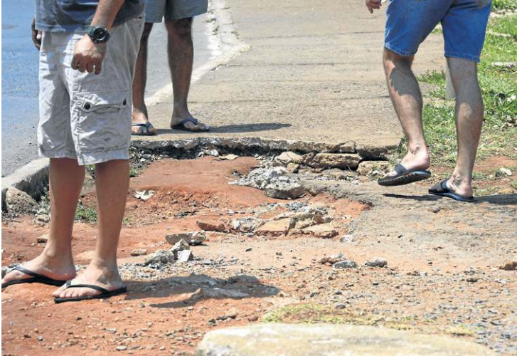
Serão construídos 11.135m 2 de calçadas acessíveis
