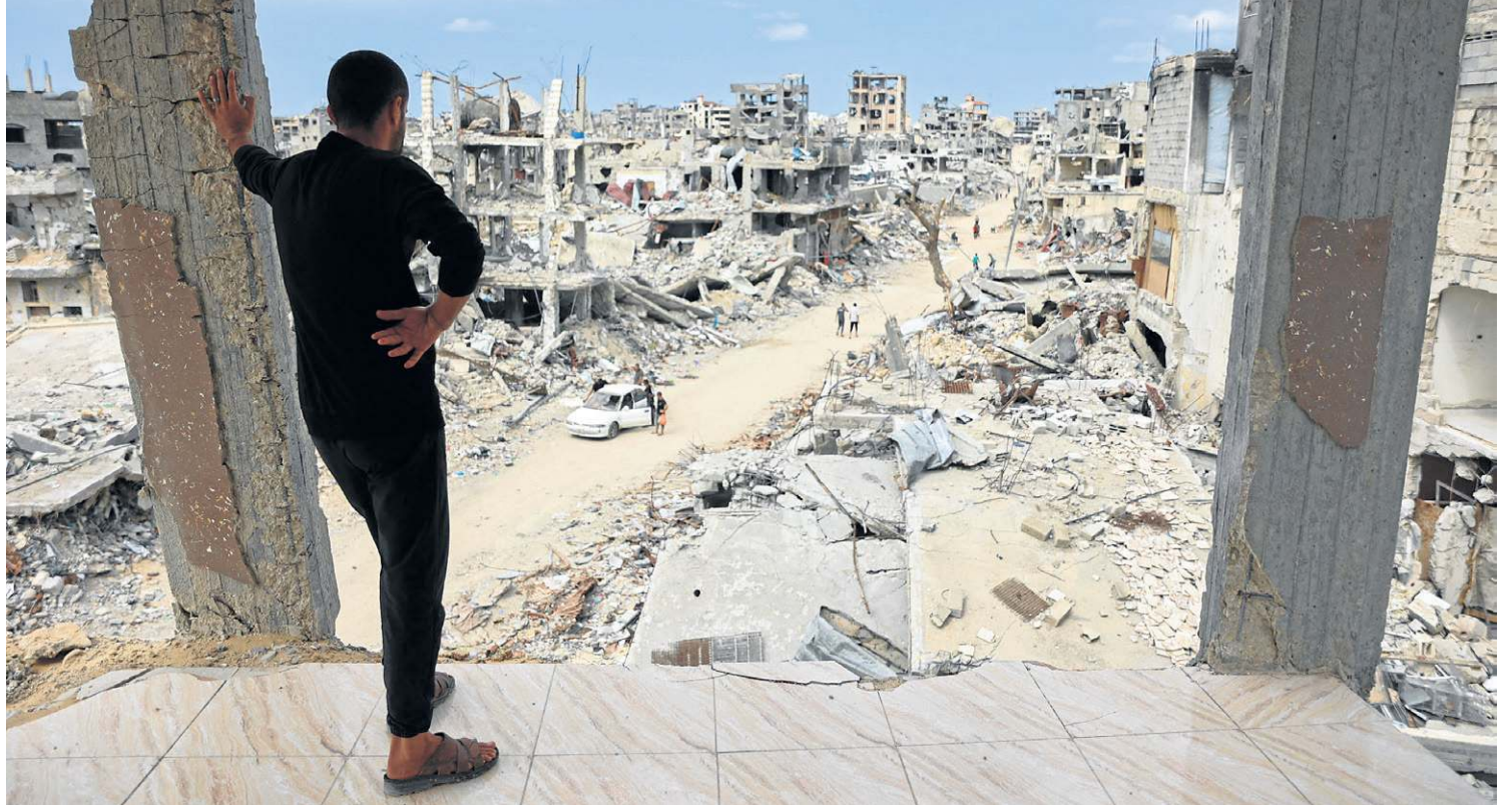
Prédios destruídos no bairro de Shujaiya, na Cidade de Gaza, praticamente inabitável: antes da guerra, 500 mil pessoas viviam no local
