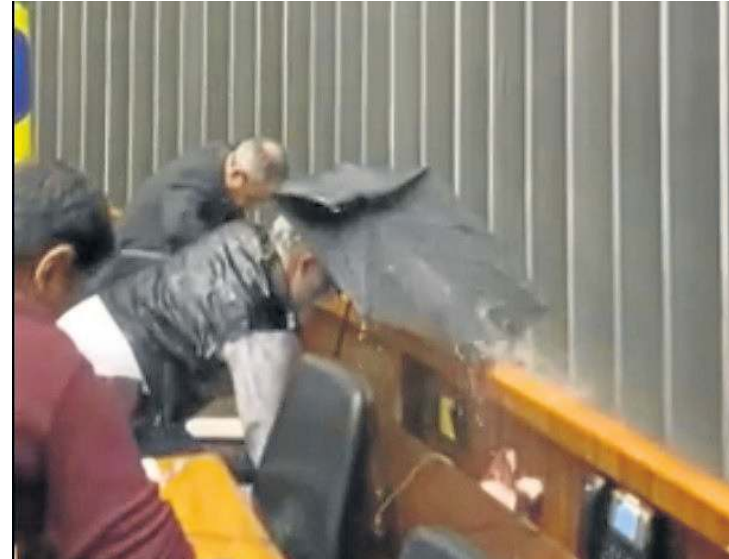
Água da cobertura invadiu Plenário da Câmara dos Deputados
