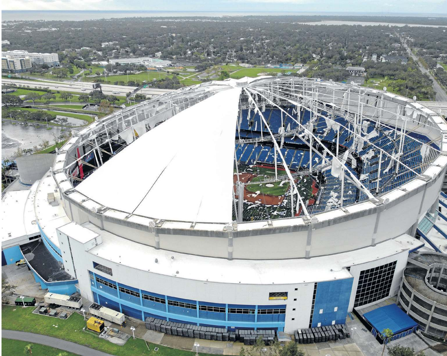
O teto do Tropicana Field, estádio da equipe de beisebol MLB Tampa Bay Rays, foi arrancado pelos ventos, na cidade de St. Petersburg
