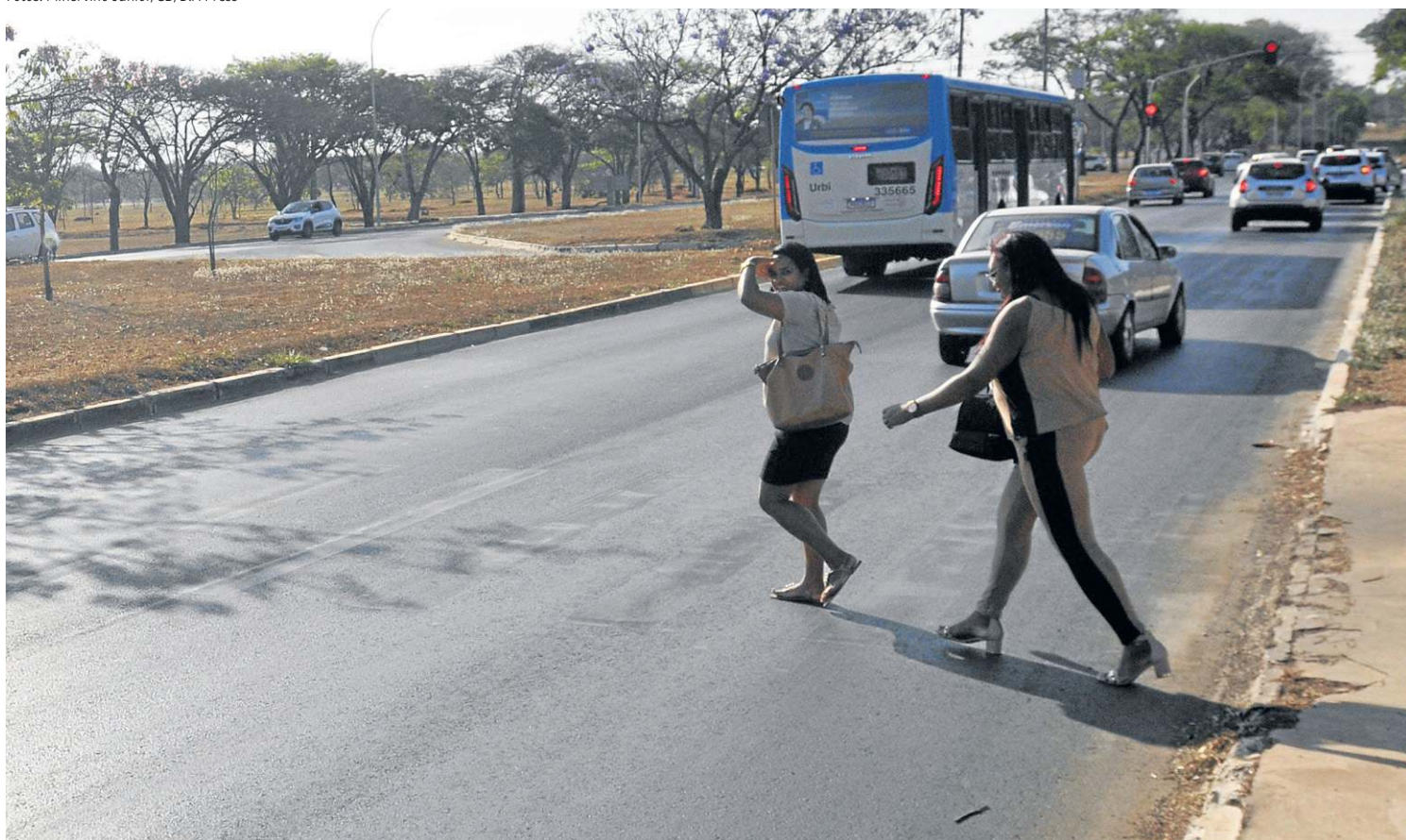
Faixa de pedestres com sinalização apagada na via L2 Sul obriga pessoas a se arriscarem na travessia. Motoristas ficam sem referência
