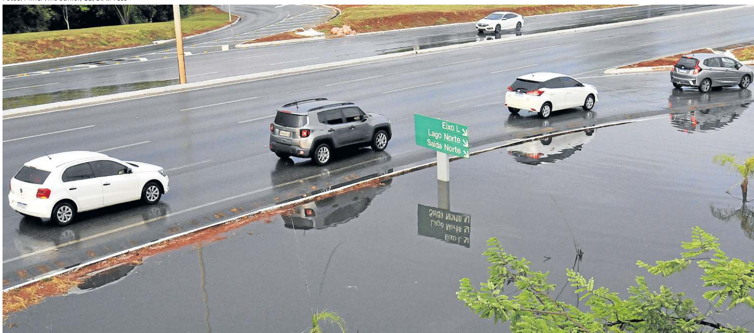
Uma boca de lobo entupida no viaduto de acesso a Ponte do Bragueto fez com que a água se acumulasse na lateral
