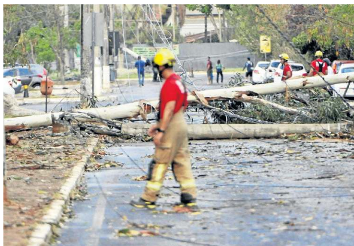
Na QI 9 do Lago Norte, a queda de um poste causou falta de energia
