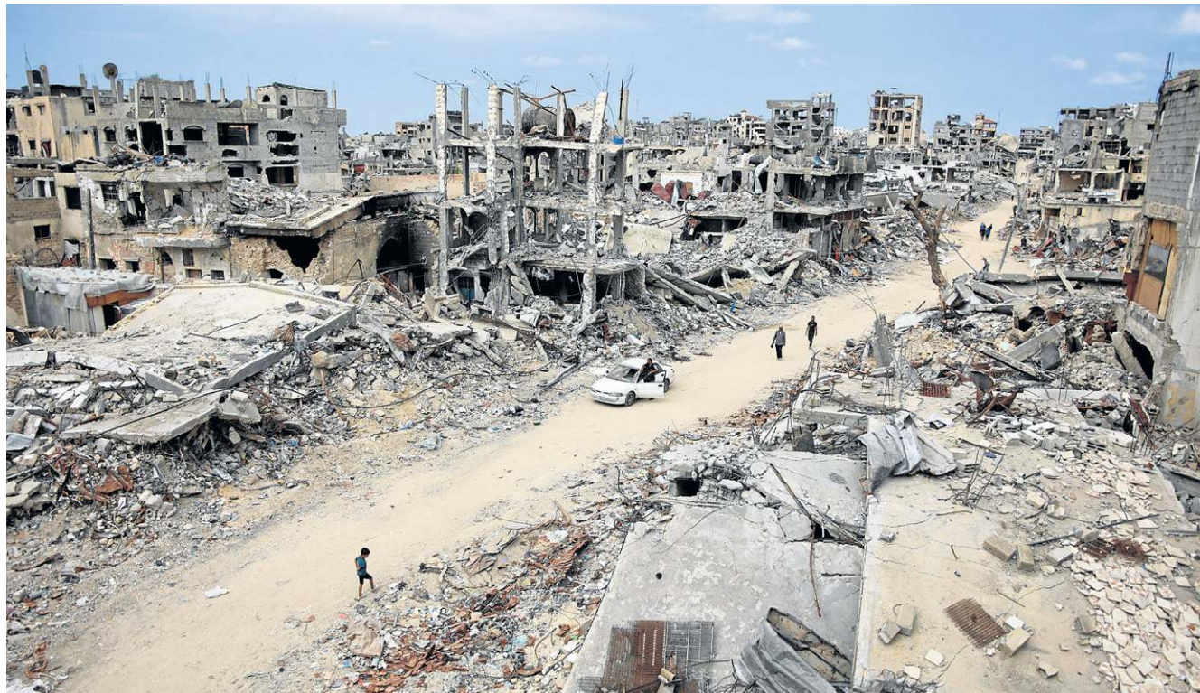
Palestinos desabrigados caminham em meio a escombros, no bairro bombardeado de Shujaiya, na Cidade de Gaza: devastação
