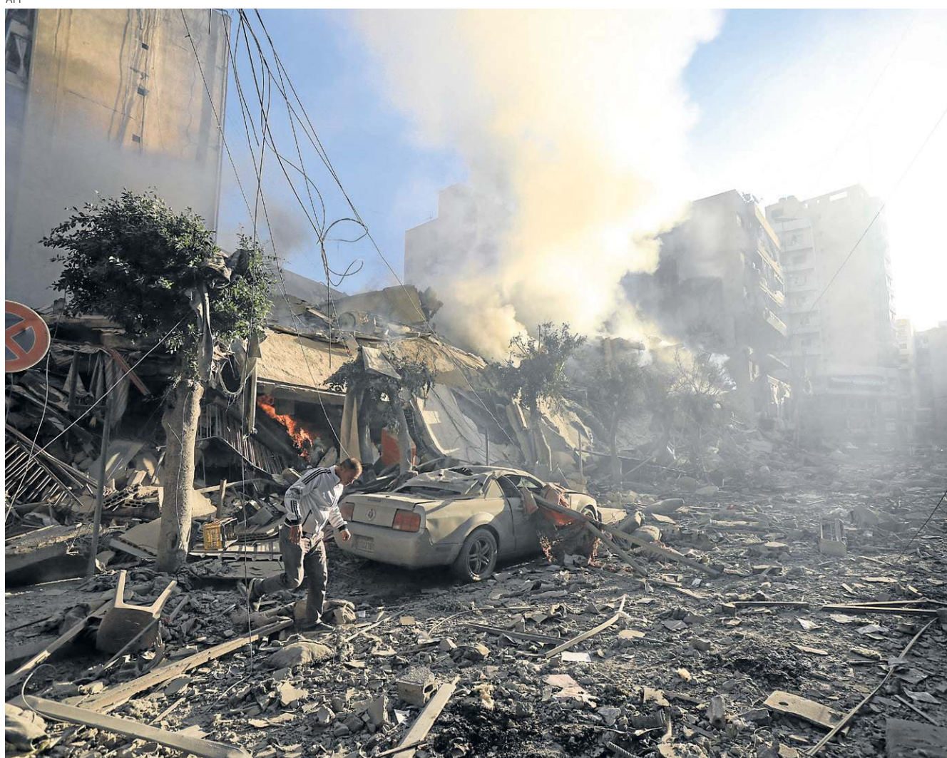
Morador de Beirute caminha sobre escombros de prédio destruído durante ataque aéreo israelense, no bairro de Moawwad (sul)
