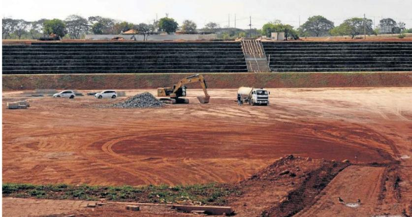
Uma bacia foi construída para que a água das chuvas possa perder força, decantar e diminuir a velocidade
