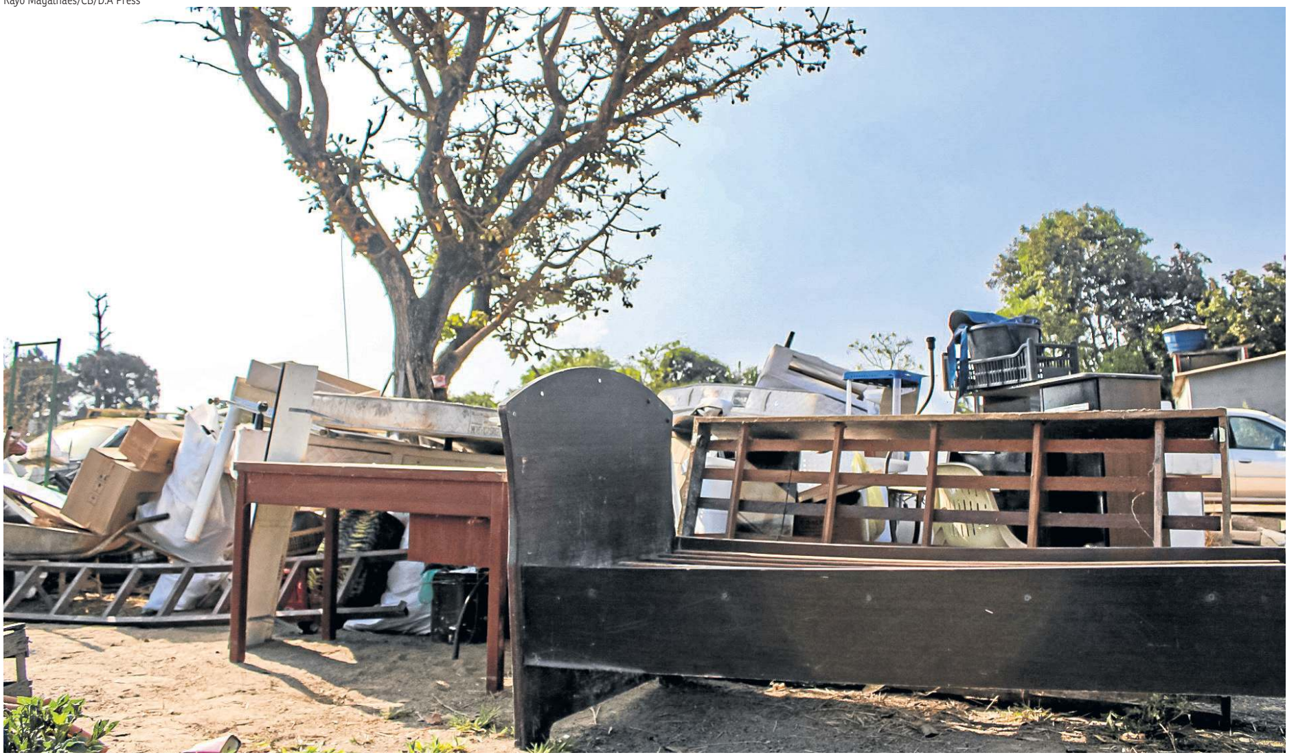
Dois casas do assentamento 26 de setembro foram demolidas na semana passada porque o local foi apontado como foco de desmatamento
