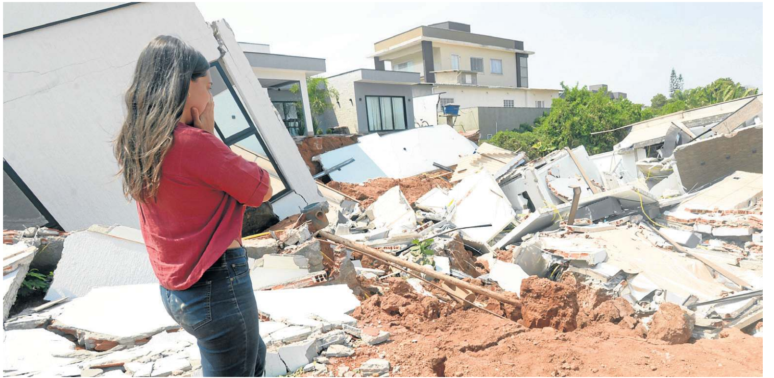
Clarissa contempla os escombros. "Uma rachadura chegou à nossa casa. Três pessoas da empresa disseram para ficarmos tranquilos"
