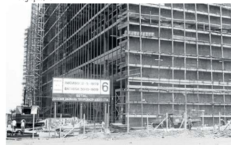
Construção do prédio do Tribunal de Justiça do Distrito Federal e Territórios em 1959
