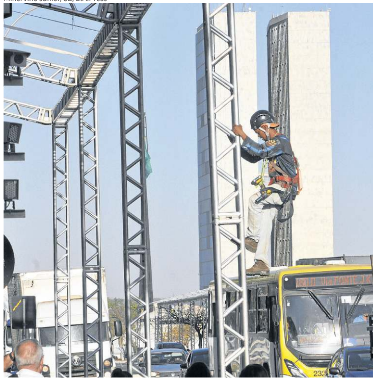
Operário trabalha na construção das estruturas para o público
