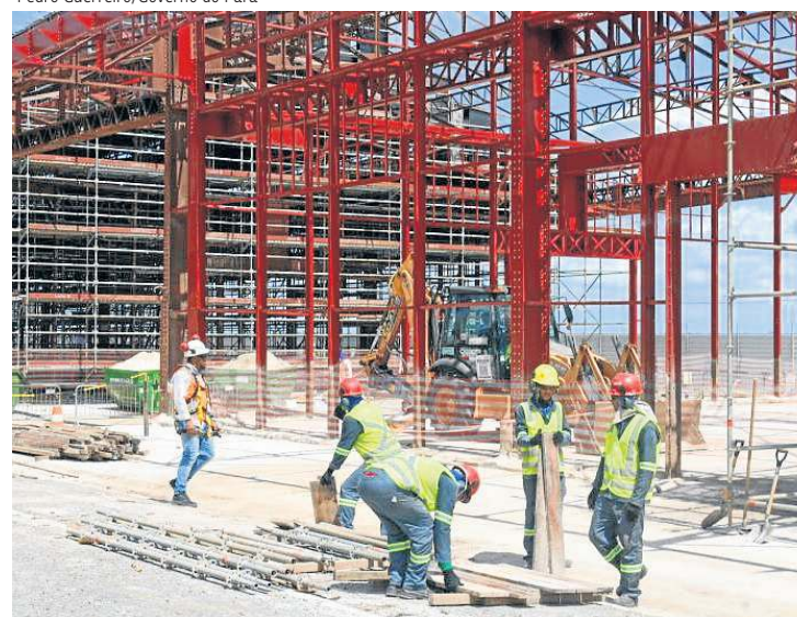
Porto Futuro: obras em Belém abrangem urbanismo e infraestrutura
