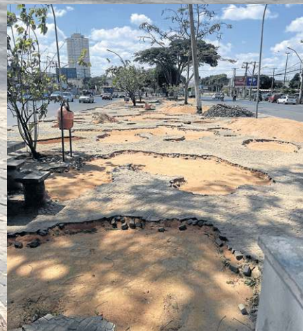
Trecho próximo ao 8ºGBM está com a retirada das pedras mais avançada
