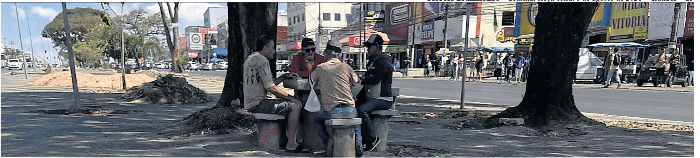
Proximidades da mesa de dominó em Ceilândia com a calçada retirada
