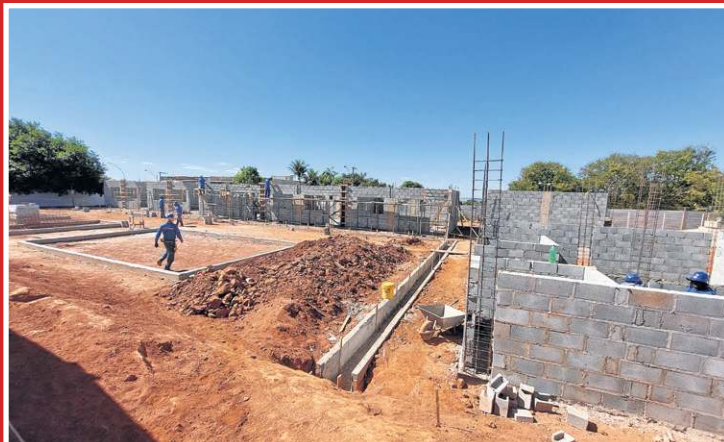
O novo bloco de salas está em construção
