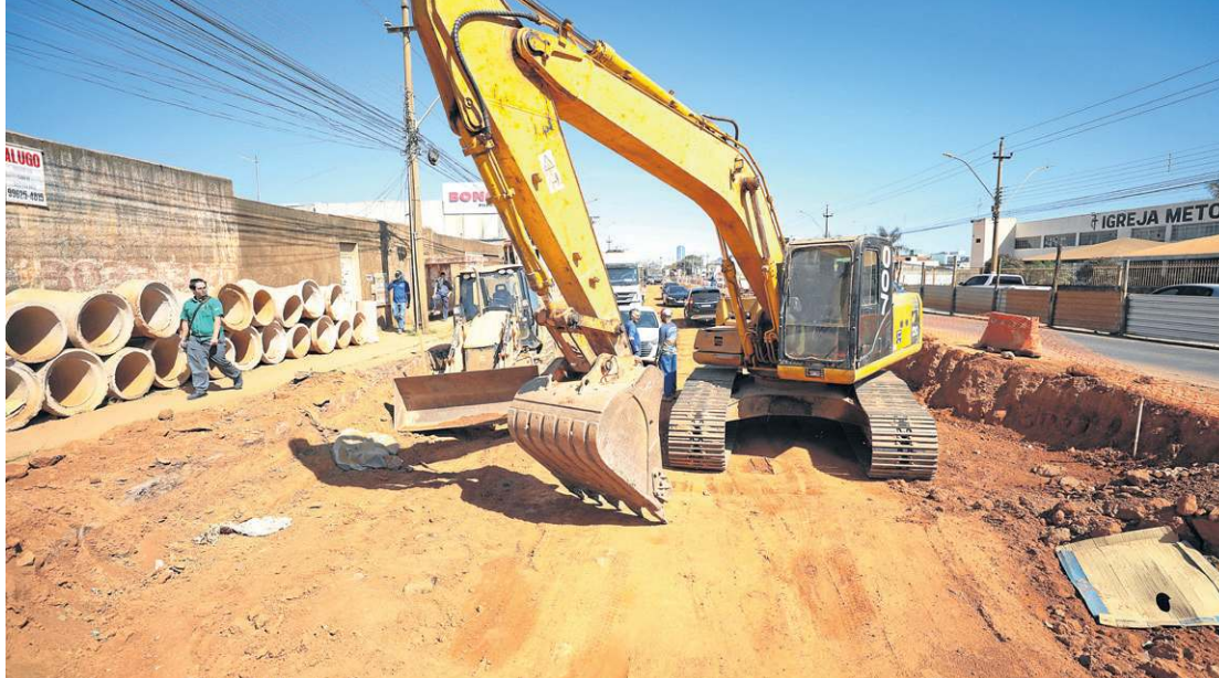
Governo vai entrar com material de acabamento para a pavimentação, maquinário e mão de obra
