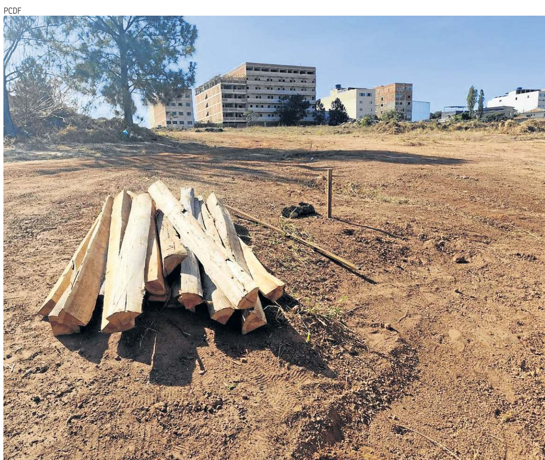
Estacas eram para loteamento ilegal em área ambiental. Investigados podem ter penas de até oito anos
