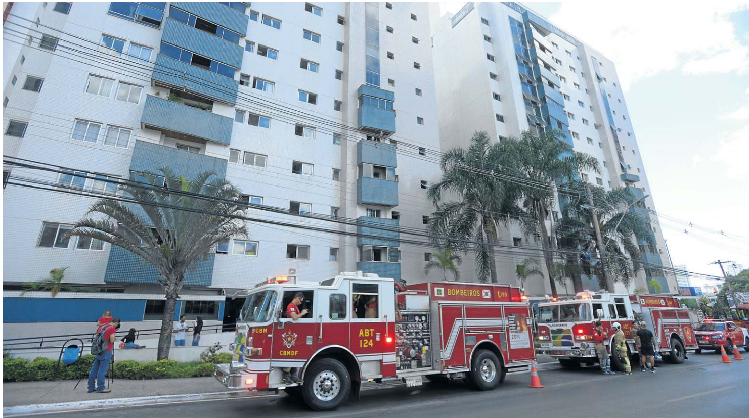
Várias equipes foram mobilizadas para controlar o fogo, na manhã de ontem, em apartamento do Residencial Monet, em Águas Claras
