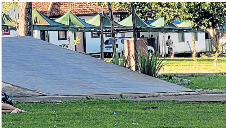
Ontem, a passarela para procissão foi construída em frente à igreja
