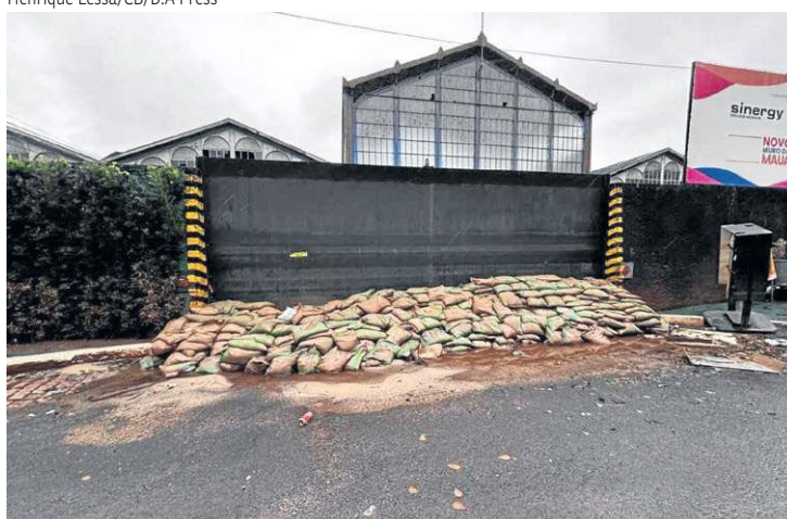
Sacos colocados na frente de uma comporta para tentar conter a inundação
