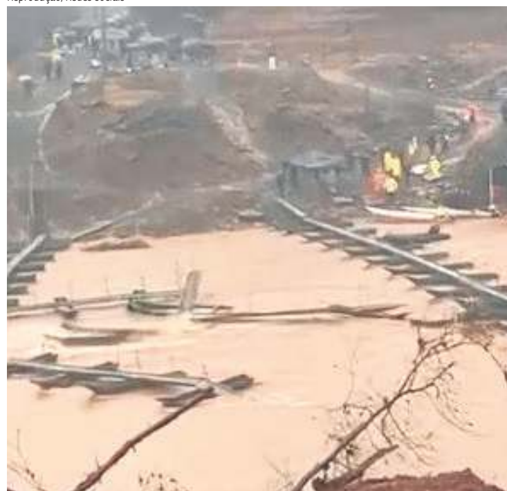
Ponte erguida pelo Exército não resistiu à força da correnteza
