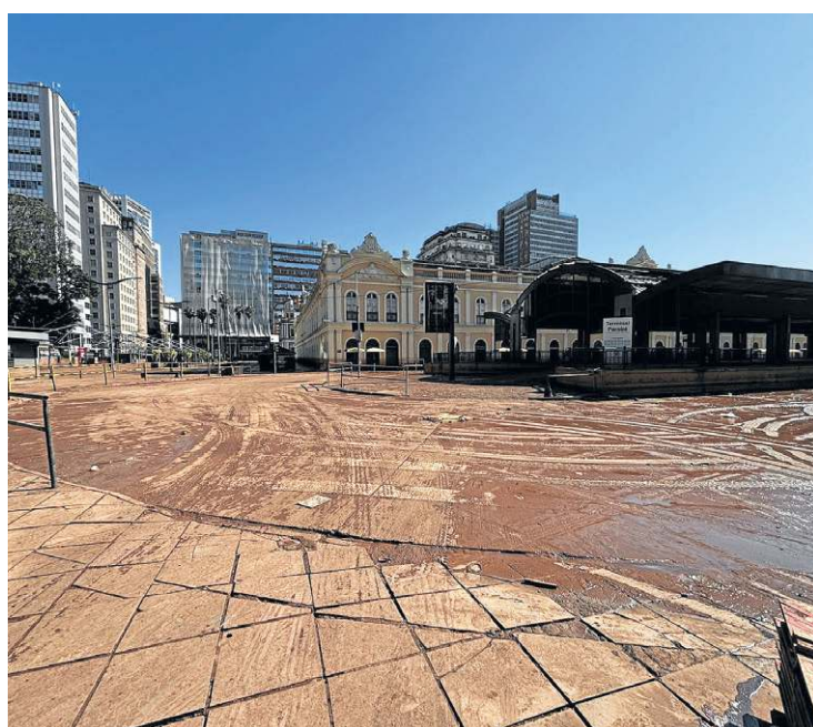
Na região do Terminal Parobé, só parte da lama pode ser retirada a máquina
