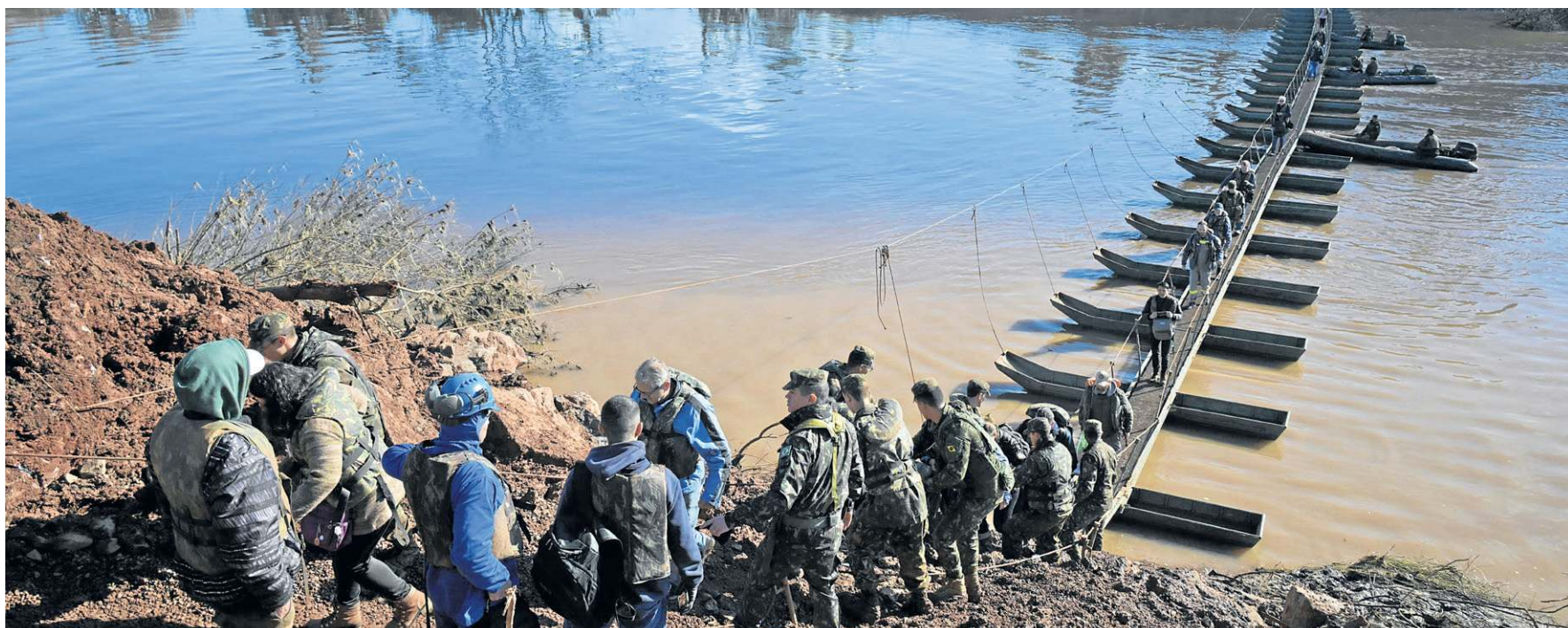
Exército faz estrutura provisória entre Arroio do Meio e Lajeado: ponte foi destruída e áreas estavam isoladas. Frio de 15°C, em média, aflije população
