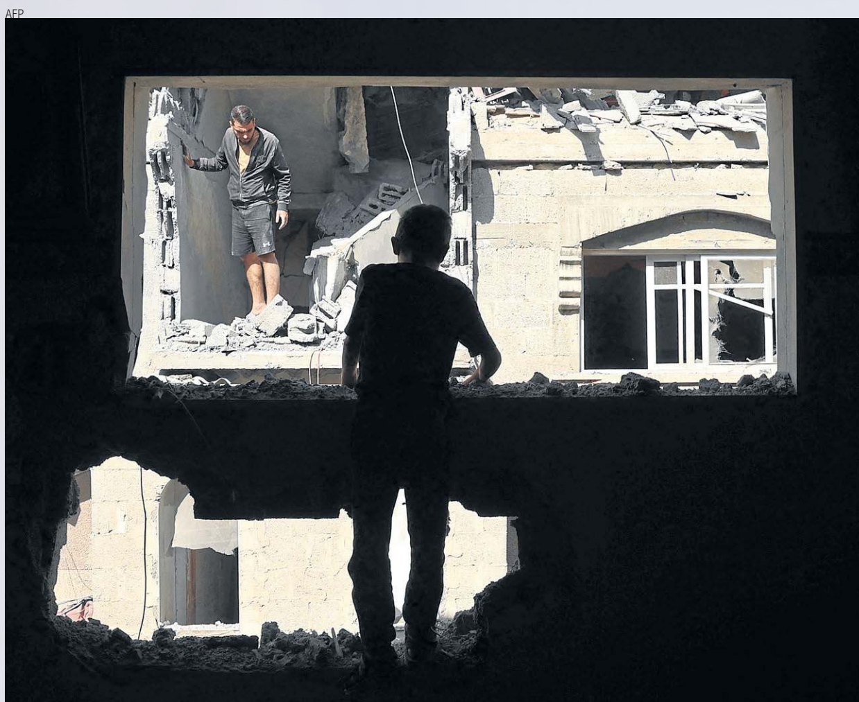
Palestinos inspecionam os danos provocados por bombardeio israelense em uma casa, na cidade de Rafah
