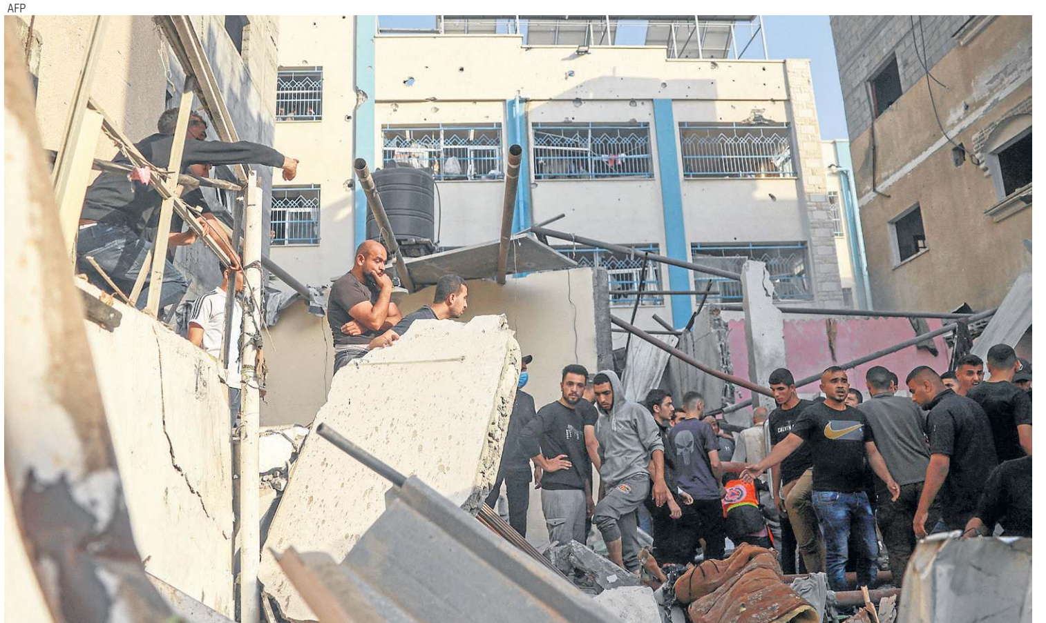
Palestinos buscam por sobreviventes nos escombros de prédio destruído após bombardeio israelense em Rafah, no sul do enclave
