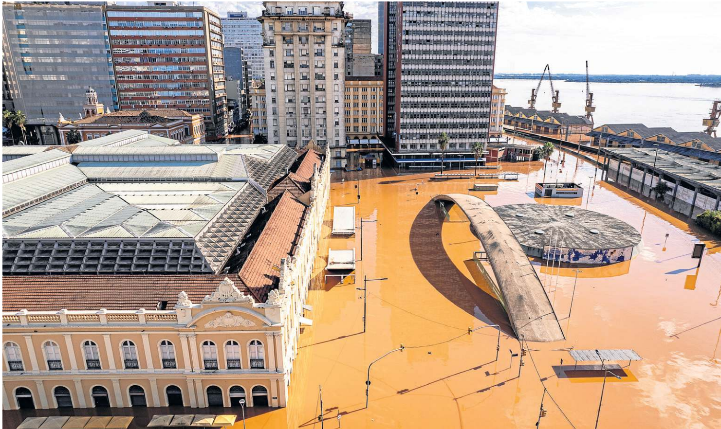
Centro de Porto Alegre, em frente ao Mercado Público, está debaixo d’água. O transbordamento do Guaíba inundou uma boa parte do bairro
