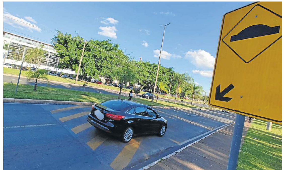
As sinalizações vertical e horizontal são essenciais
