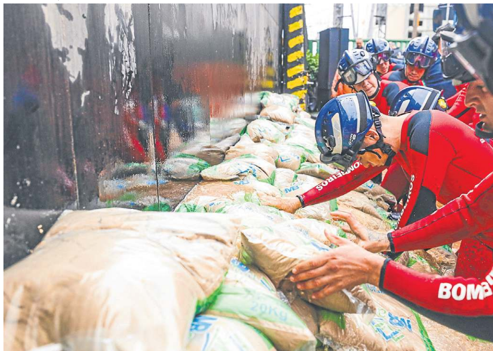
Bombeiros empilham sacos de areia nas comportas do Guaíba para barrar o avanço da enchente
