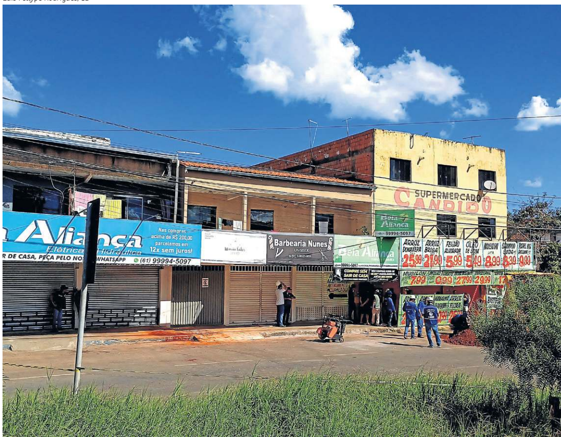
Residências e lojas comerciais foram evacuadas e interditadas pela Defesa Civil
