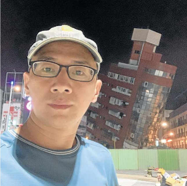
Zola Zhou, morador de Ruisui, diante de edifício inclinado
