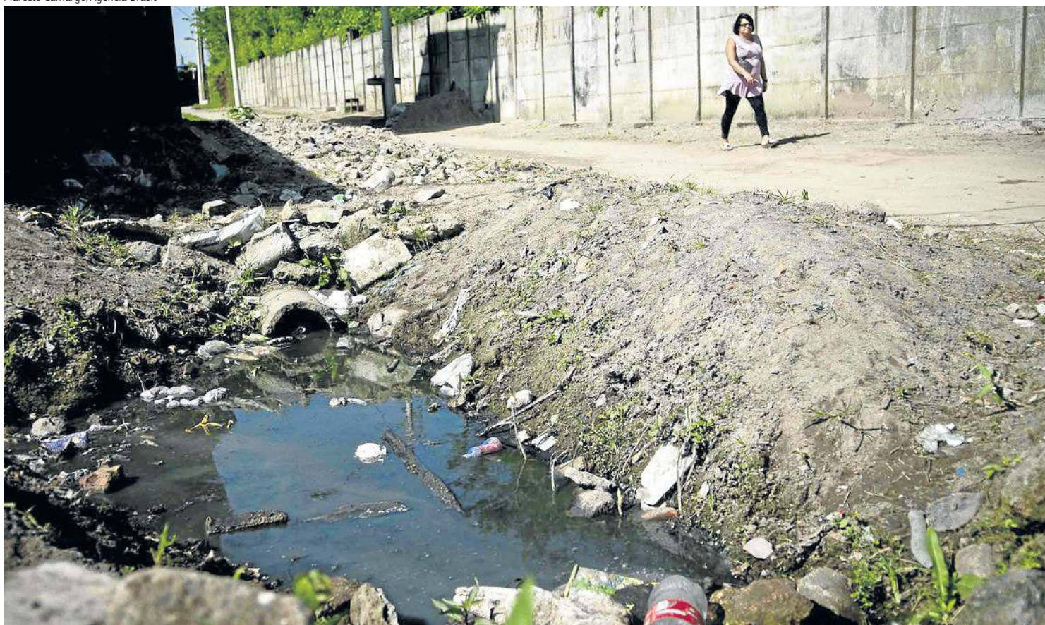
Esgoto a céu aberto: um problema difícil de ser superado e que afasta o país das metas estabelecidas pelo Marco do Saneamento Básico
