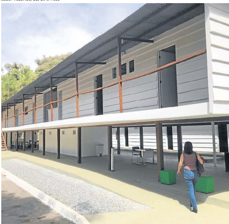
As estruturas do Catetinho exigem conservação qualificada
