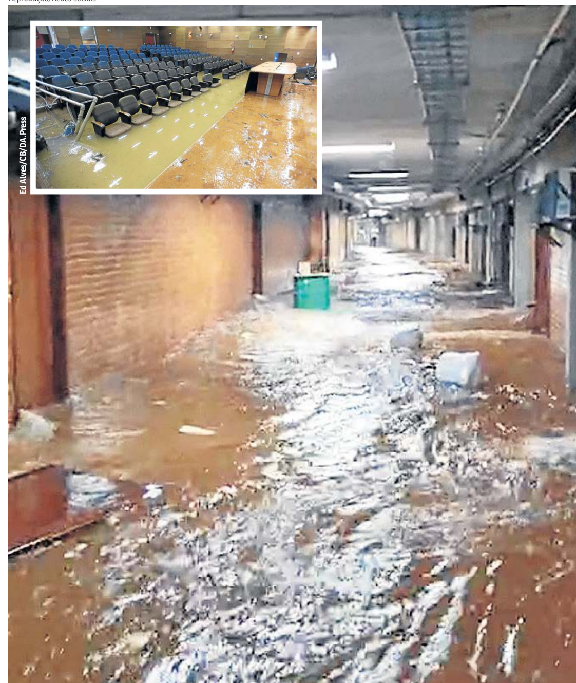
Com sistema de drenagem arcaico, a água escorre para a UnB e invade o subsolo de prédios da universidade
