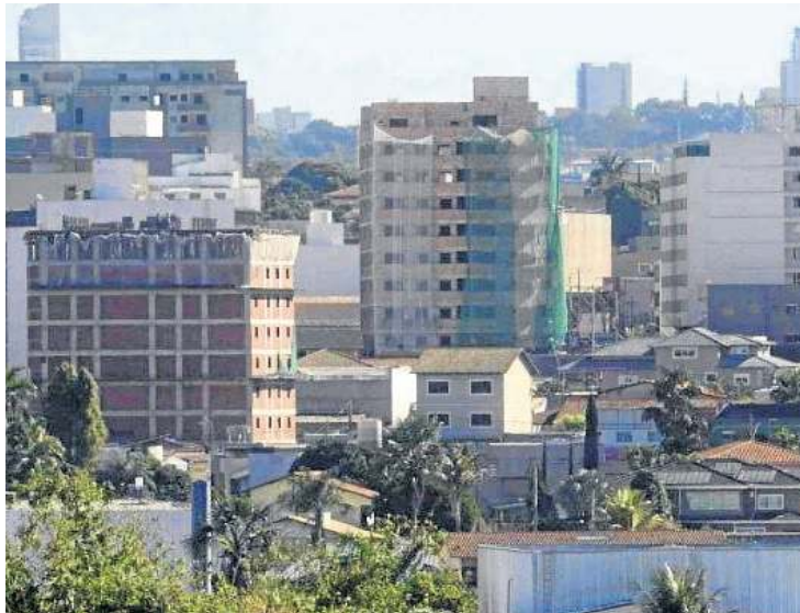
Processo de regularização do Trecho 2 se iniciou com o cadastramento
