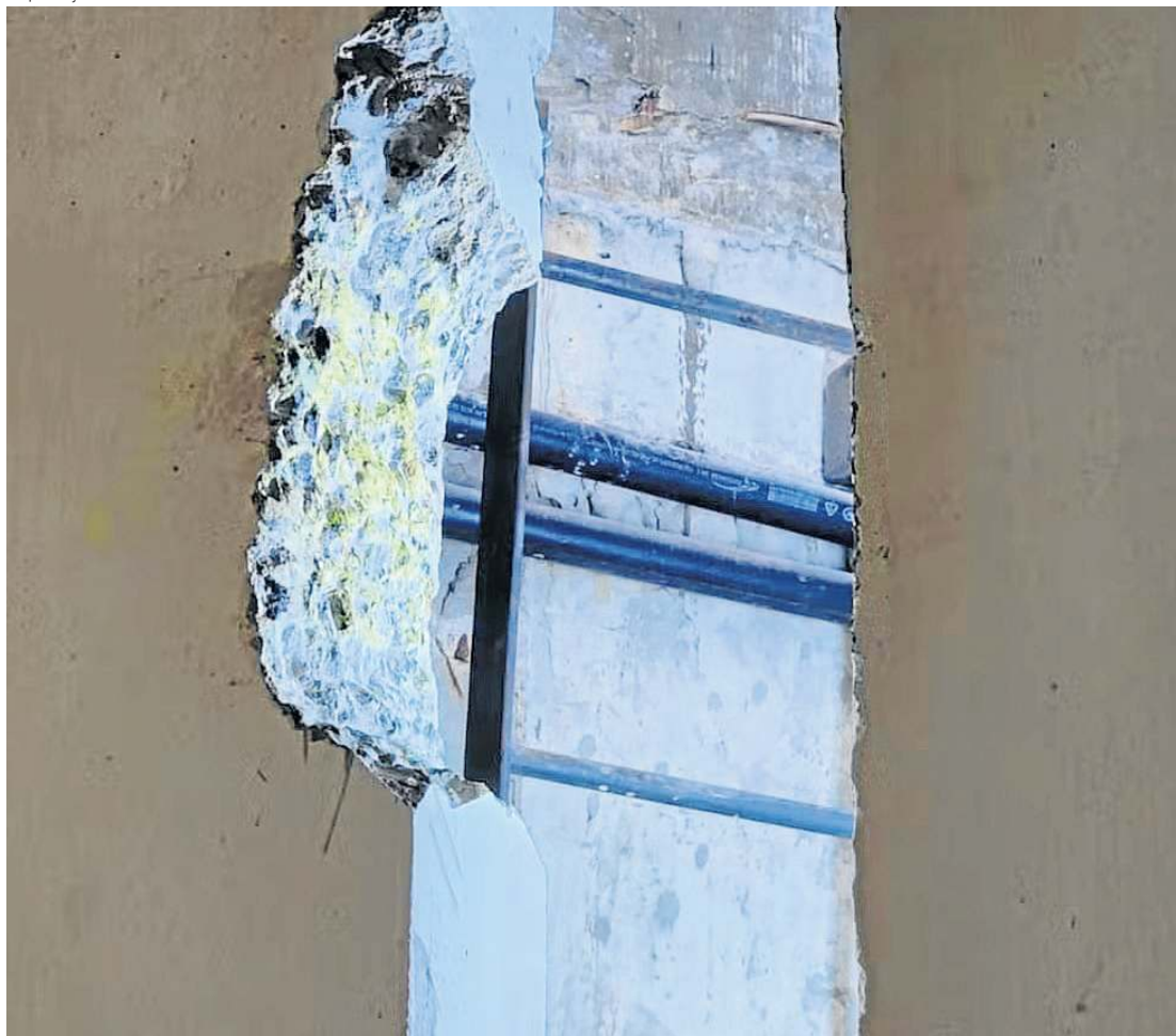
Imagem divulgada ontem mostra um buraco na cela de um dos detentos que escaparam
