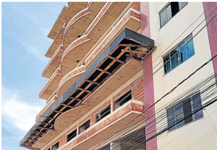
Moradores denunciam que obras estão sendo tocadas à noite
