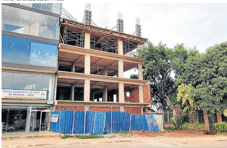
Alguns prédios estão somente com a estrutura básica erguida
