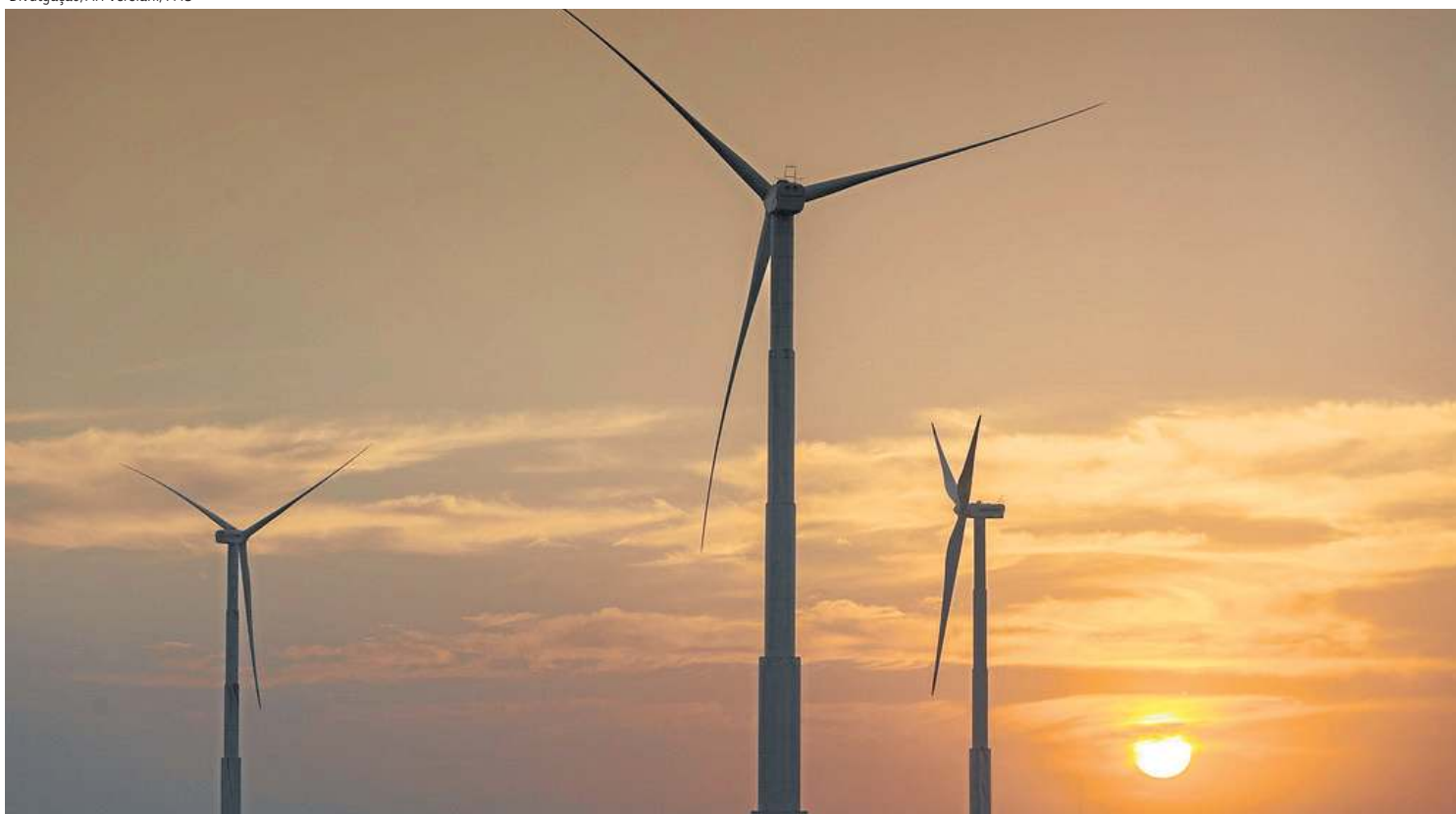
Usina de Energia Eólica em Icarai (CE): Brasil se destaca pelo aumento da participação de fontes renováveis, reduzindo o uso de termelétricas
