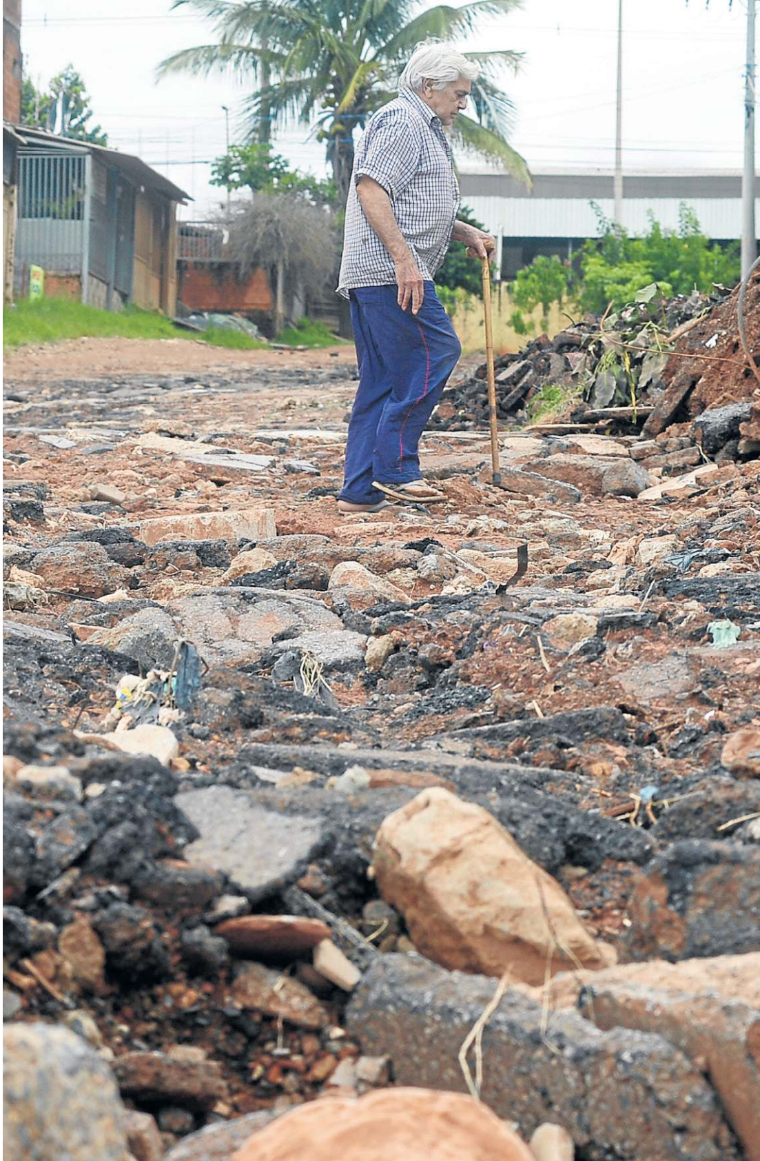
Rua com destroços no Pôr do Sol não ajuda o aposentado João Alves, que tem dificuldade de locomoção
