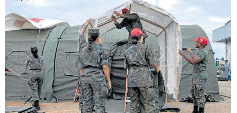
Hospital Força Aérea Brasileira sendo montado em Ceilândia
