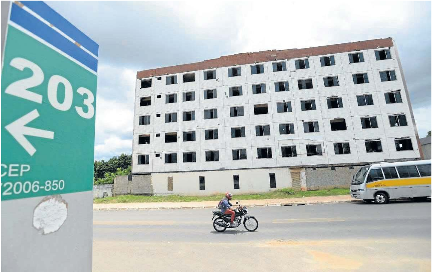
Na Rua 8 de Vicente Pires, imóvel vazio preocupa moradores por possíveis focos do mosquito da dengue que podem estar se acumulando
