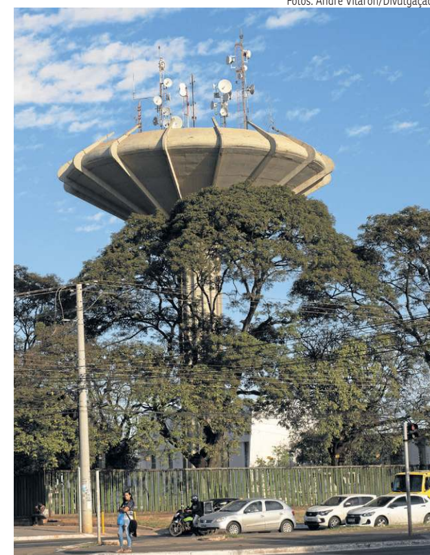
▲ Caixa D'Água de Ceilândia
