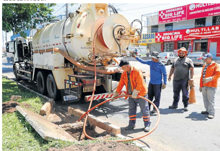
Bocas de lobo e galerias de escoamento foram limpas pela Novacap
