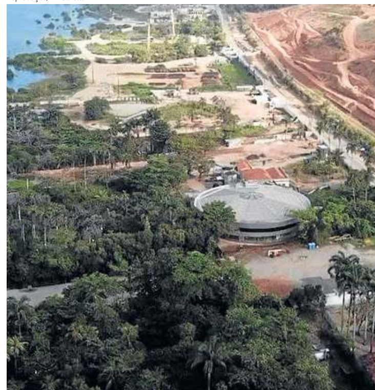
Afundamento ocorreu próximo à Lagoa Mundaú, no bairro do Mutange
