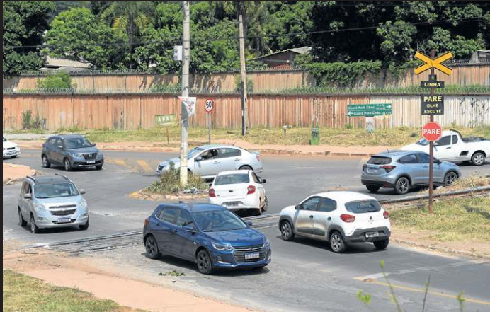
No Guará, próximo à colônia agrícola Águas Claras, a linha férrea está bem ao lado de uma creche. A sinalização horizontal é praticamente inexistente e há um desnível na pista
