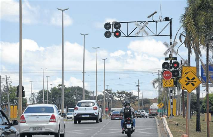
Logo abaixo, outro cruzamento está com a sinalização em melhor estado. Além das placas indicativas, existem sinais semafóricos e a pintura da via está conservada
