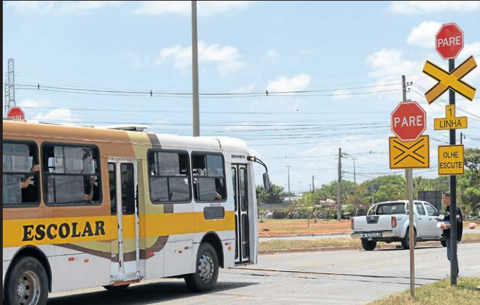
No local da tragédia, apenas a sinalização vertical está em bom estado de conservação. Na pista, as pinturas que indicam o cruzamento com a linha férreas estão apagadas
