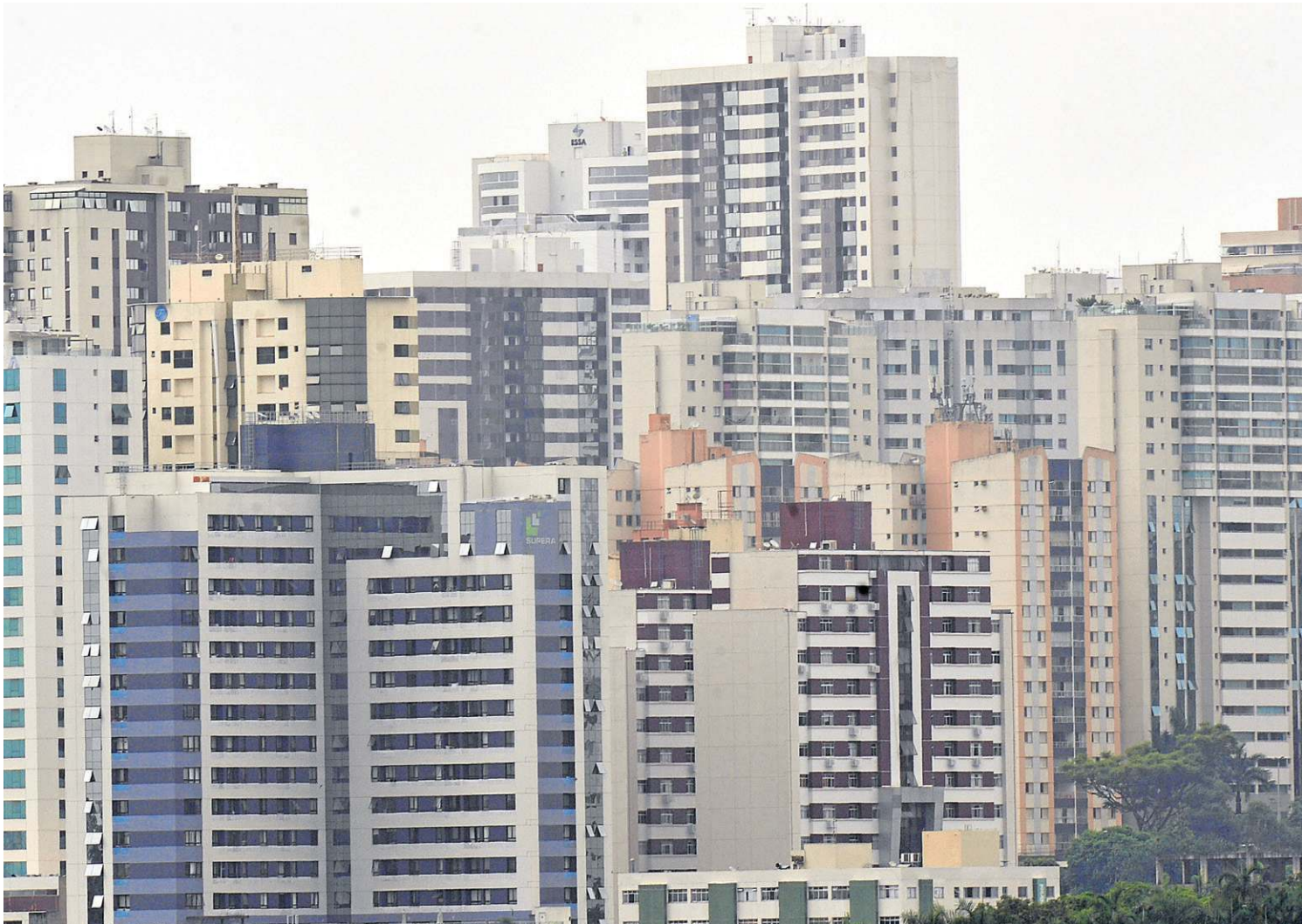
Em Águas Claras, o problema é o grande volume de construção em um prazo curto, aponta especialista
