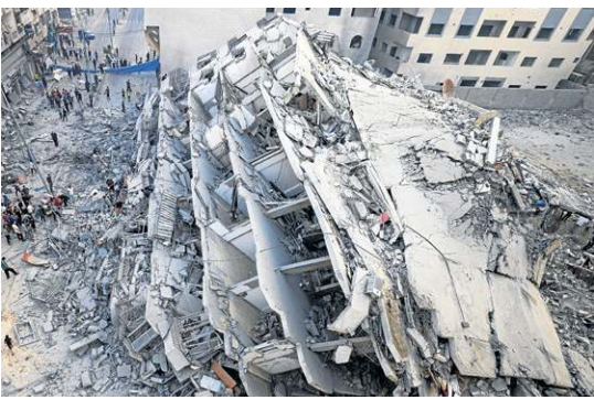
Ruínas de edifício no enclave, que está sem luz e e internet. Netanyahu quer tirar todos os cidadãos
