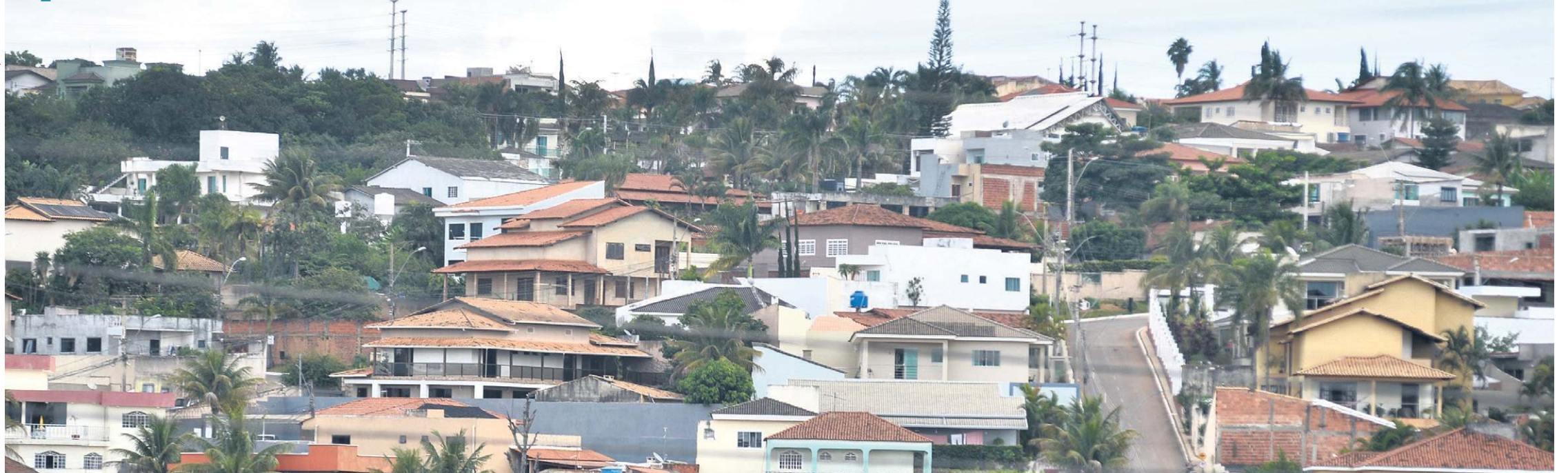
Uma força-tarefa intensificou as ações de combate a ação de grileiros e construção de prédios irregulares em Vicente Pires
