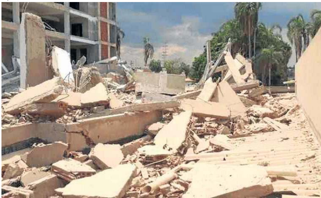
Em outubro de 2017, um prédio desabou, no lote 2A, da chácara 149, matando Agmar Silva, de 55 anos
